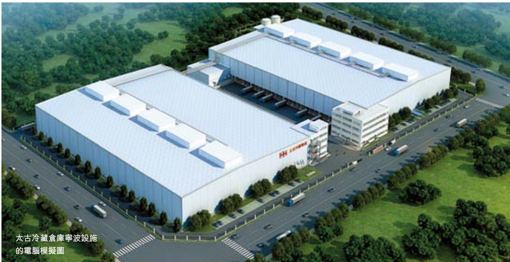
太古冷藏倉庫的寧波設施於二零一五年開始投入運作。
